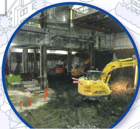
大手町高層ビル(逆打ち工法)
