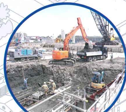
新浦安リゾートホテル プロジェクト新築工事
