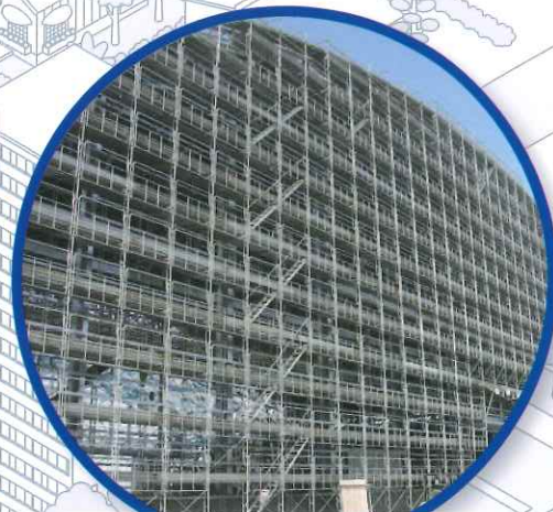
陸上自衛隊木更津(19) 整備場A新設建替工事
