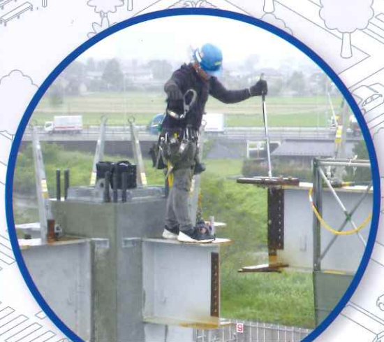
加須物流センター新築工事
